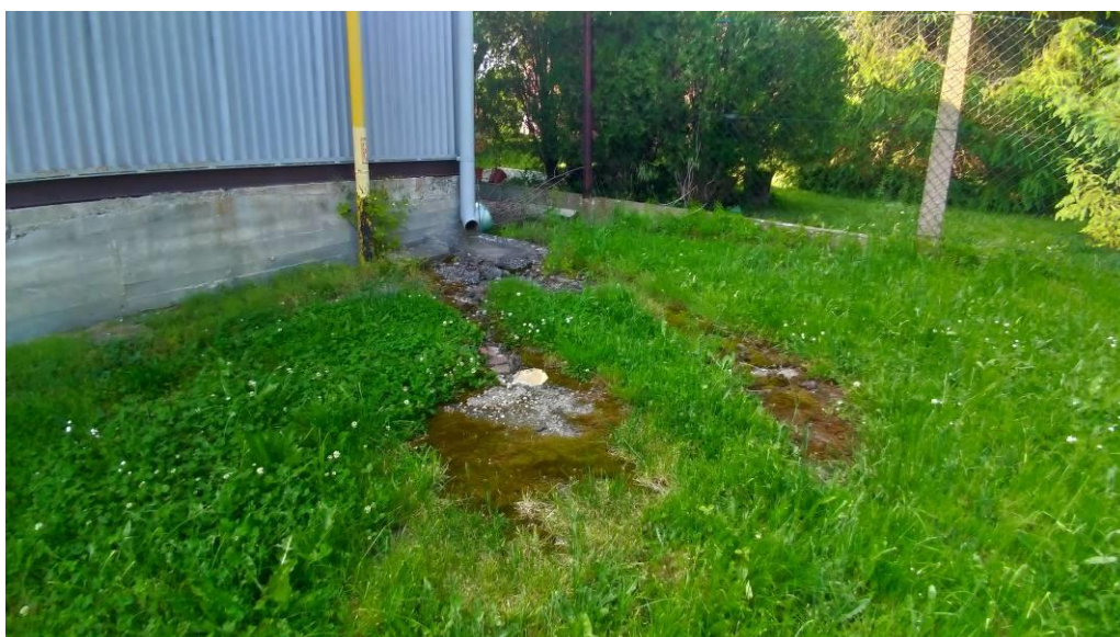
Zbytky betonového povrchu pod druhou okapovou rourou
